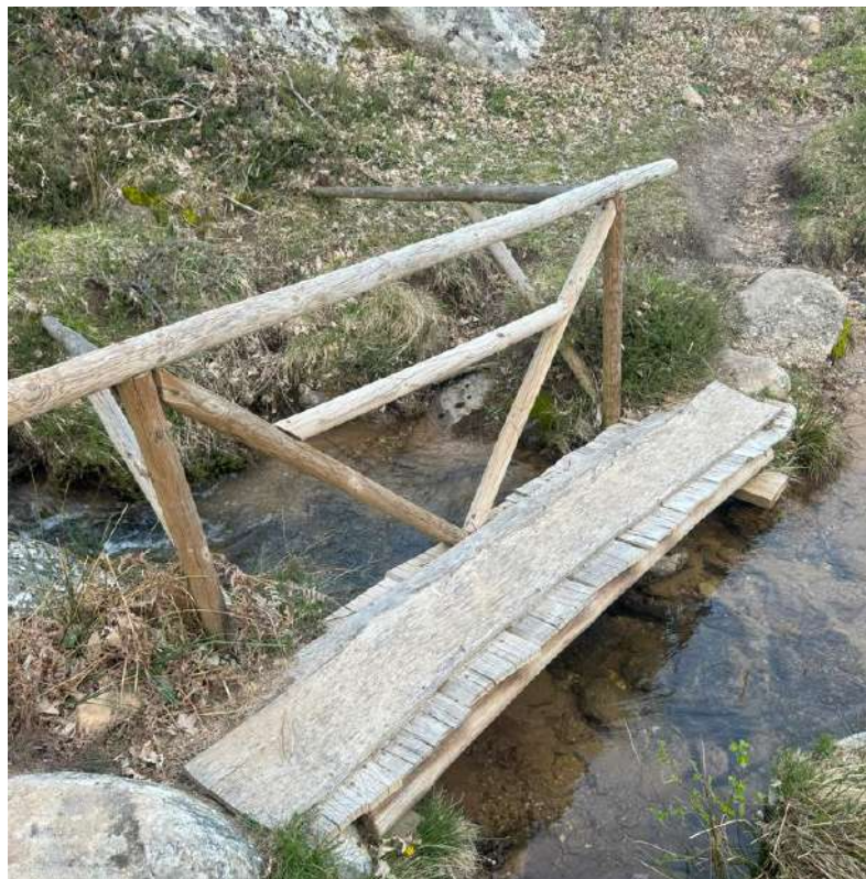
Retirada y sustitución de la pasarela actual en el Arroyo Lechoso
