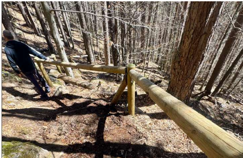
Ejemplo de Pasamanos en el acceso a la Cascada de la Mina del Médico
